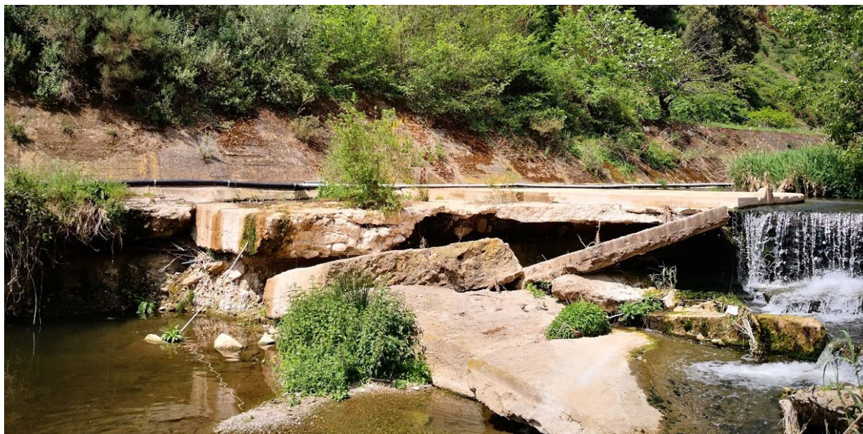
Descalçat i esfondrament de l'aforador al final de la canalització de Can Barba
